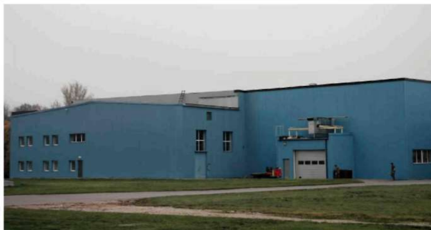
Офисный комплекс ООО «Циль-Абегг»
