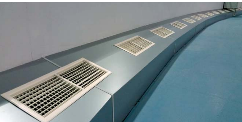
Рис. 5. Распределяющие решётки нижней раздачи притока
