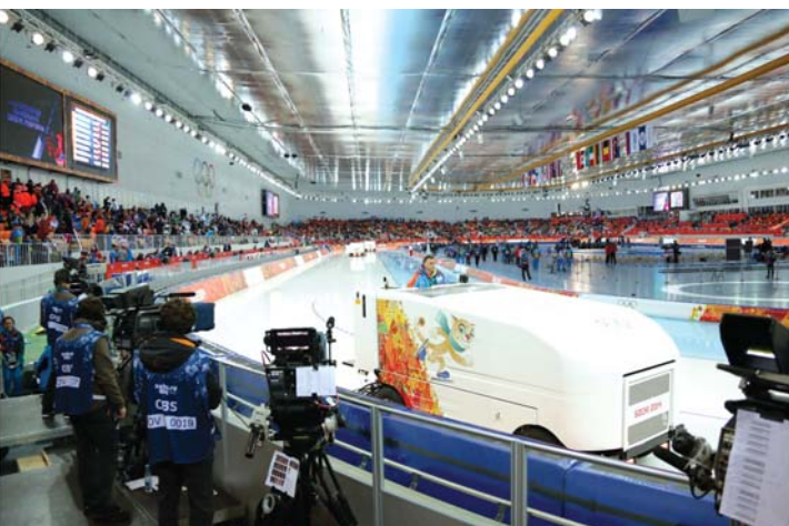
Рис. 3. Общий вид арены крытого катка «Адлер-Арена»
