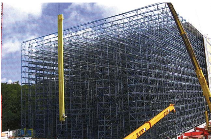
Фото 1. Конструкция высотных стеллажей-опор склада-холодильника
