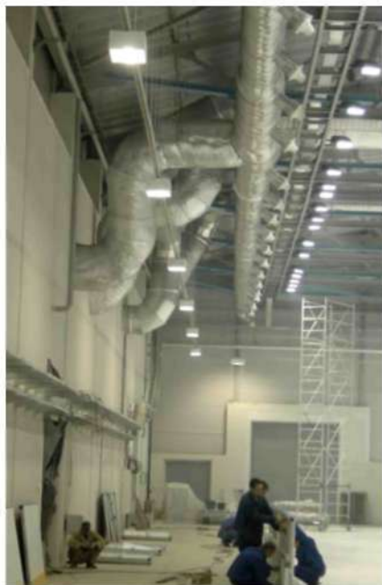
Монтаж системы вентиляции в Ледовом дворце в Мытищах
