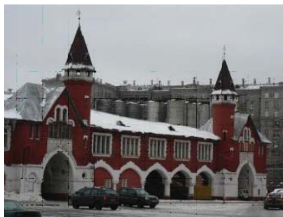
Рис. 4. Трехгорный пивоваренный завод
