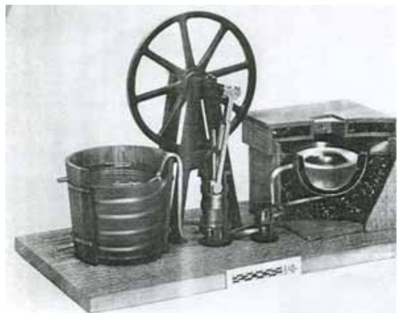
Рис.2. Холодильная машина Перкинса-Твиннинга
