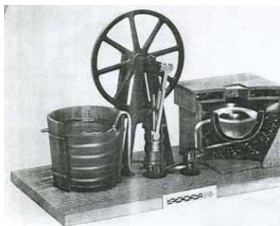
Рис.2. Холодильная машина Перкинса-Твиннинга
