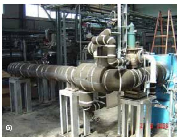
**Рис. 2.** Изоляция скорлупами FOAMGLAS® трубопроводов различного назначения.
