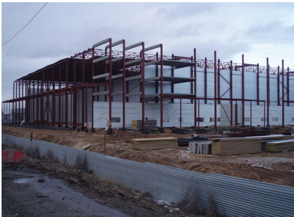
Фото 3. Строительство блока холодильного терминала «Арт-Лоджистик»
