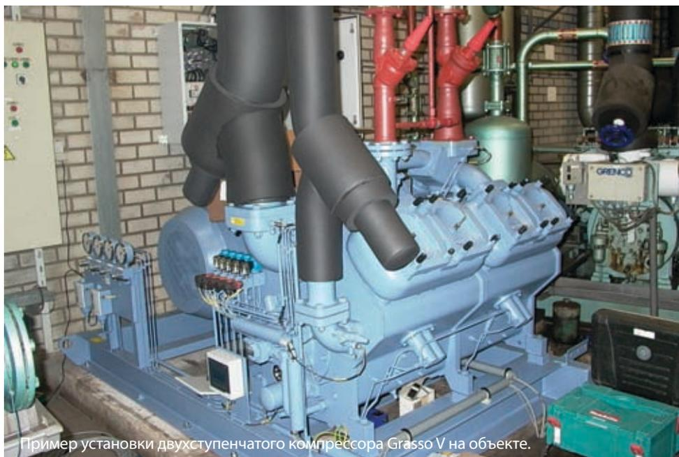
Пример установки двухступенчатого компрессора Grasso V на объекте.
