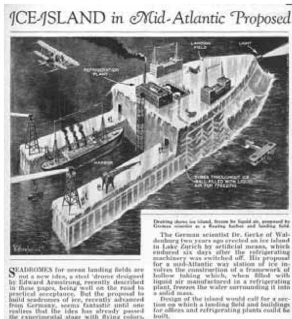
Рис.2. Проект охлаждаемого жидким воздухом плавучего ледового острова, используемого как порт и аэродром [17].
