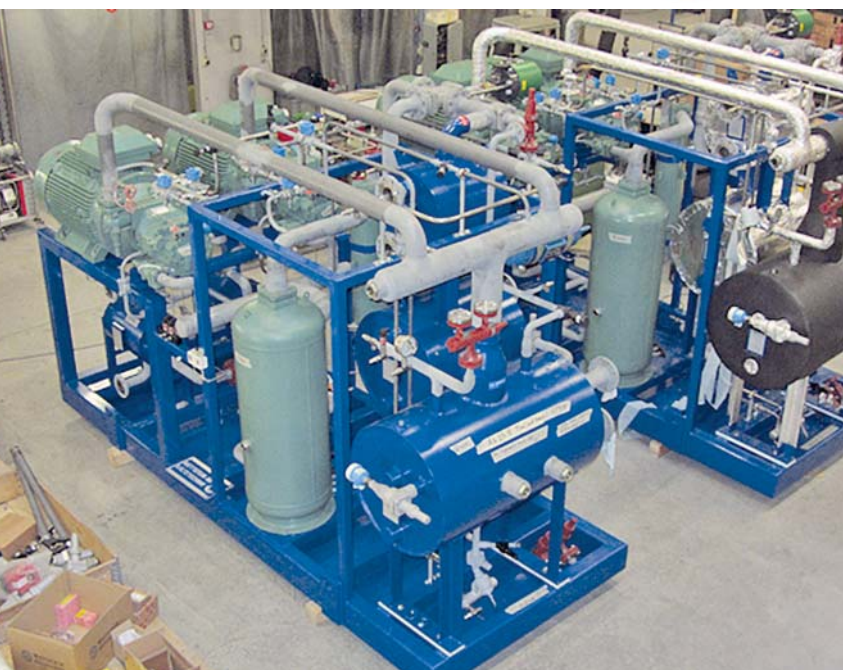
Проектирование и изготовление модуля на заводе Walter Wettstein AG в городе Гюмлиген, Швейцария
